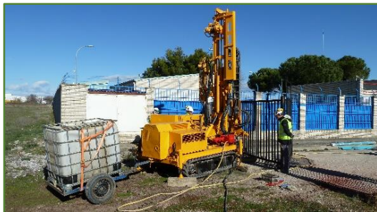
Foto 1. Ejecución de sondeo para toma de muestras
