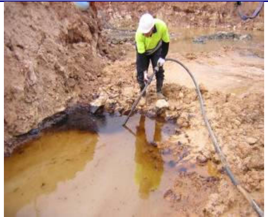
Extracción de hidrocarburo en fase libre con slurpers
