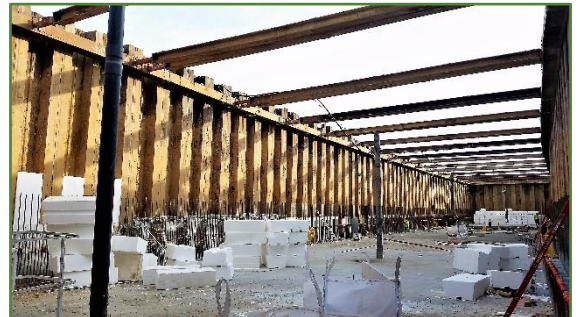
Foto 6. Recinto con tablestacas.
