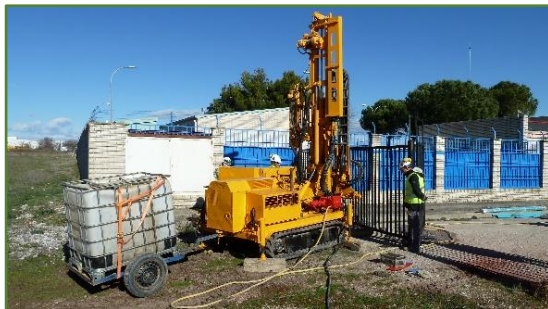
Foto 1. Ejecución de sondeo para toma de muestras
