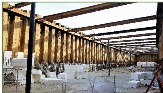
Foto 6. Recinto con tablestacas.
