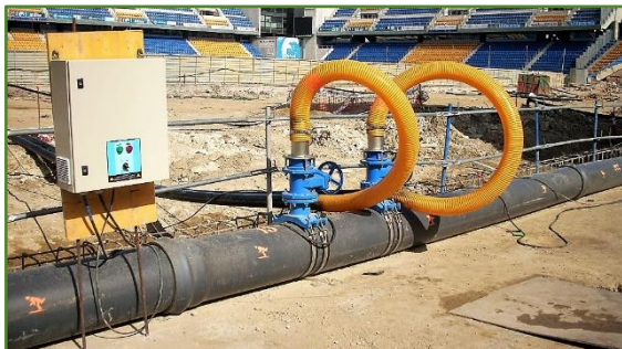
Foto 4. Cuadro de control.
